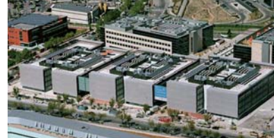
Fig1. Las Rozas Business Center, BAT - Buro Arquitectura Textil
